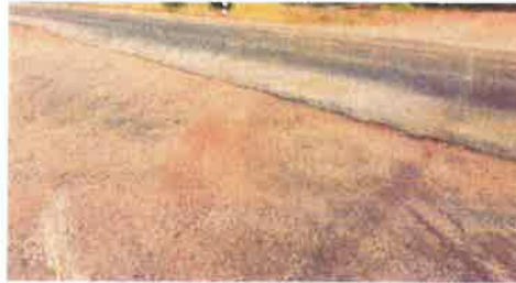
หมู่ที่ ๒ ไม่มีป้ายบนทางสาธารณะ
