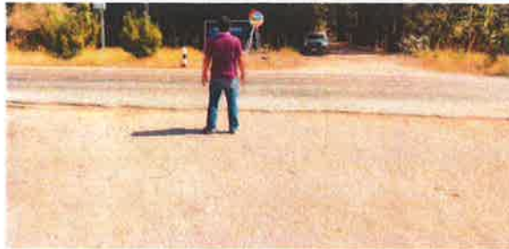
หมู่ที่ ๗ ไม่มีป้ายบนทางสาธารณะ
